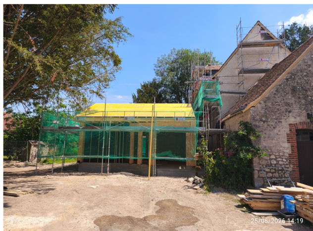
L'extension en cours de construction
